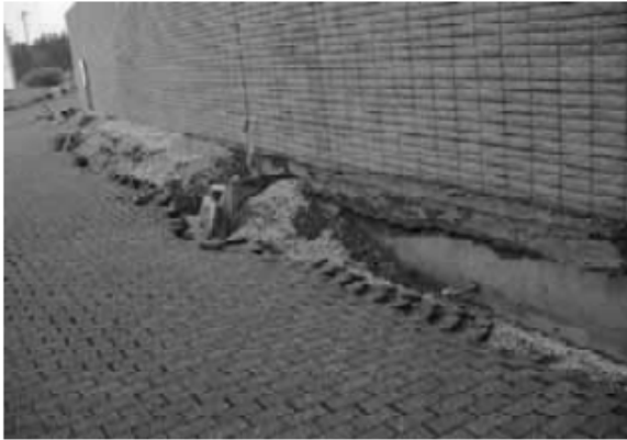
地盤の沈下（質問2）
