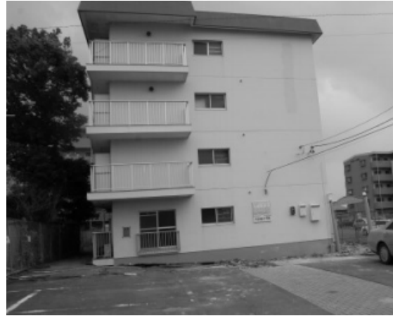
建物・床の傾斜（質問3・4）
