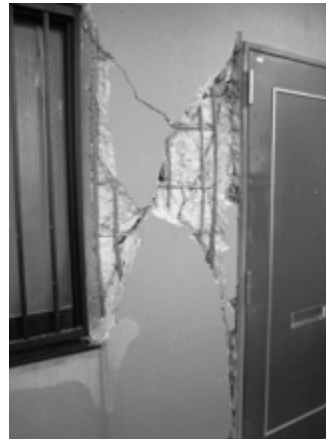
壁の破損（質問6）
