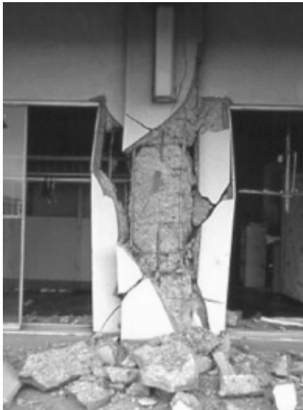
柱の破損（質問5）
