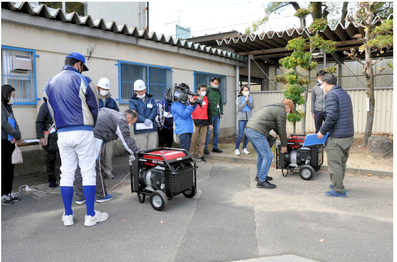
発電機の起動訓練
